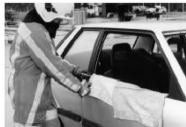
gebruik beschermhoes bij verwijderen beweegbare ruit
